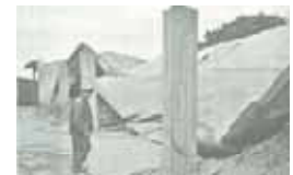
霧島山の噴火で積もった降灰により全壊した建屋(2011/2/5日本経済新聞朝刊)
